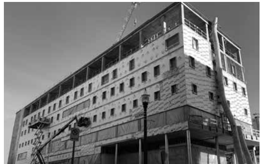
Lauberivière en construction Photo Lauberivière 2019
