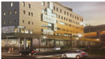
Le futur bâtiment de Lauberivière PHOTO: ANDRÉ CHABOT
